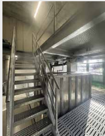
Treppe 1 OG – 2 OG, Vorlagebehälter und Zwischendecken (Stahlkonstruktionen)
