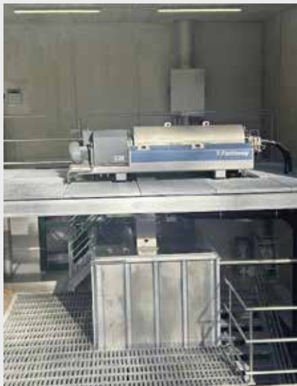
Dekanter neu, Vorlagebehälter und Stahlkonstruktionen
